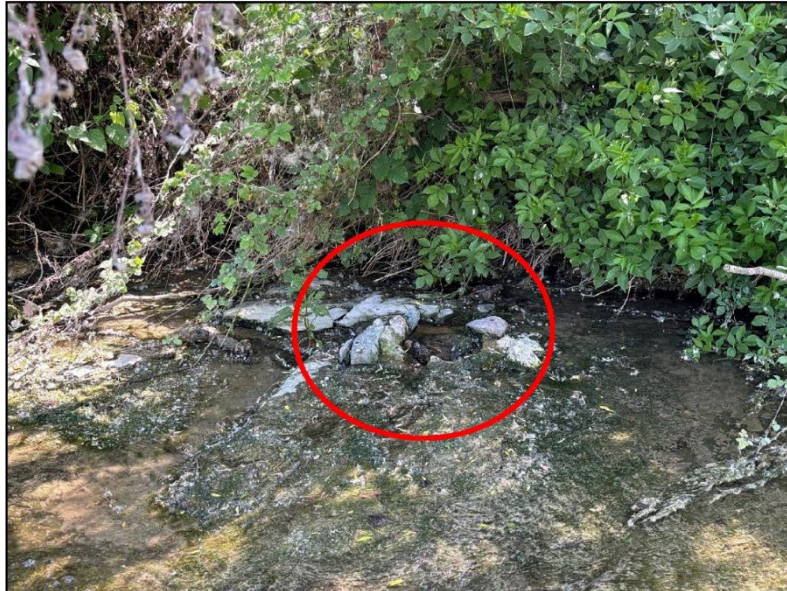
Figura 7. Se senyala el forat de pal que servia per subjectar la biga de fusta en l'extrem est d'una antiga passera
