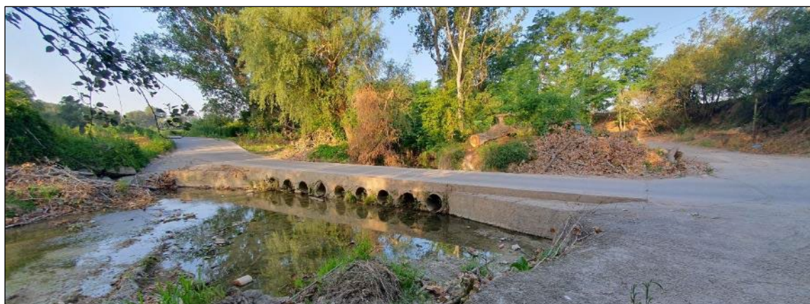
Figura 7. Vista des d'aigua avall de l'actual estructura del pas
