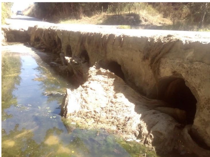
Imatge 7: Estat actual de la infraestructura del gual existent al riu Gurri
