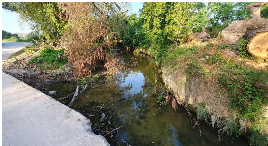
Imatge 5: Estat actual de la llera aigües avall del gual existent al riu Gurri.
