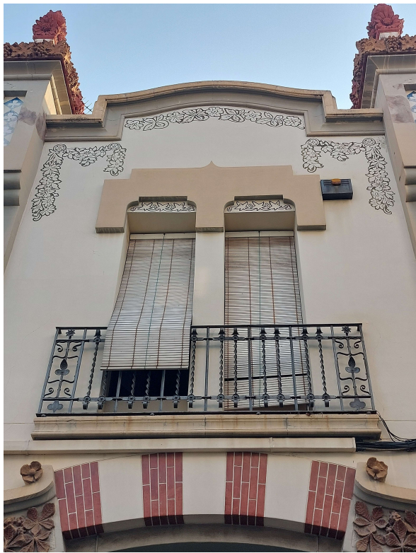
Fotografia nº3. Detall de la balconera de la planta primera façana carrer Anselm Clavé
