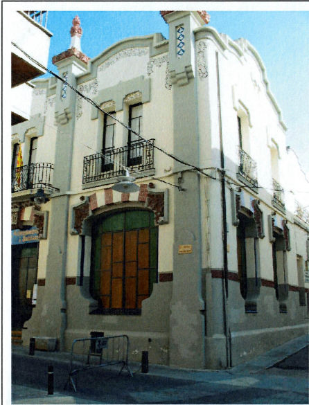
Vista de la façana del carrer Anselm Clavé
