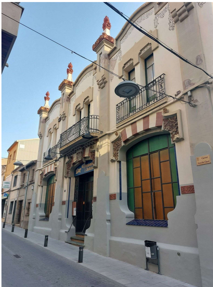
Fotografia n°2. Façana del carrer Anselm Clavé
