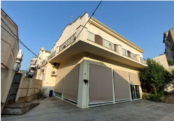
Fotografia nº4. Ampliació de l'edifici realitzada durant els anys 90
