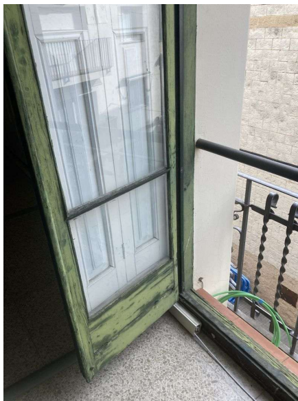
Fotografia nº5. Balconera de la planta primera de l'edifici modernista
