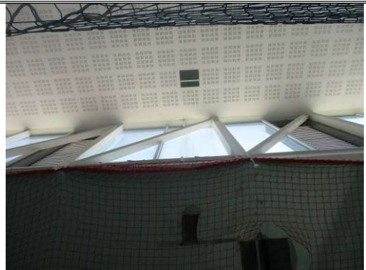
Detalles del interior alcance zona de ensayo
