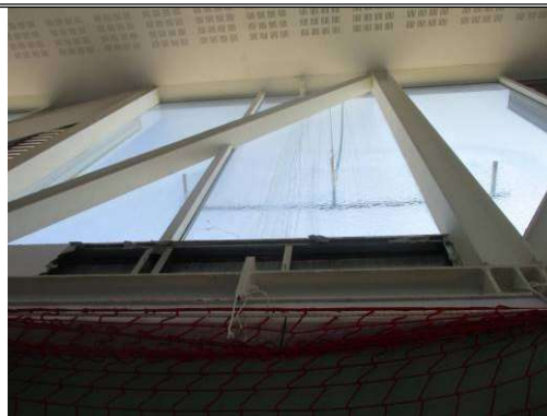
Detalles del interior alcance zona de ensayo
