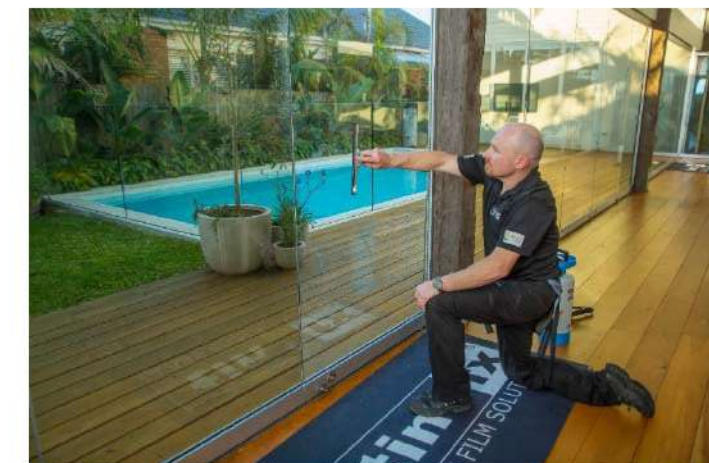
Figura 57. Instalación de un film de baja emisividad en una cristalera
