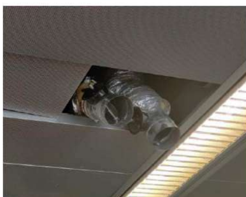
Figura 63. Conductos de climatización desconectados y redirigidos a través del falso techo
