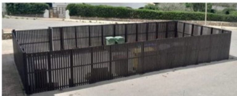
Figura 9: Estructura de tancament permeable de fusta plàstica
