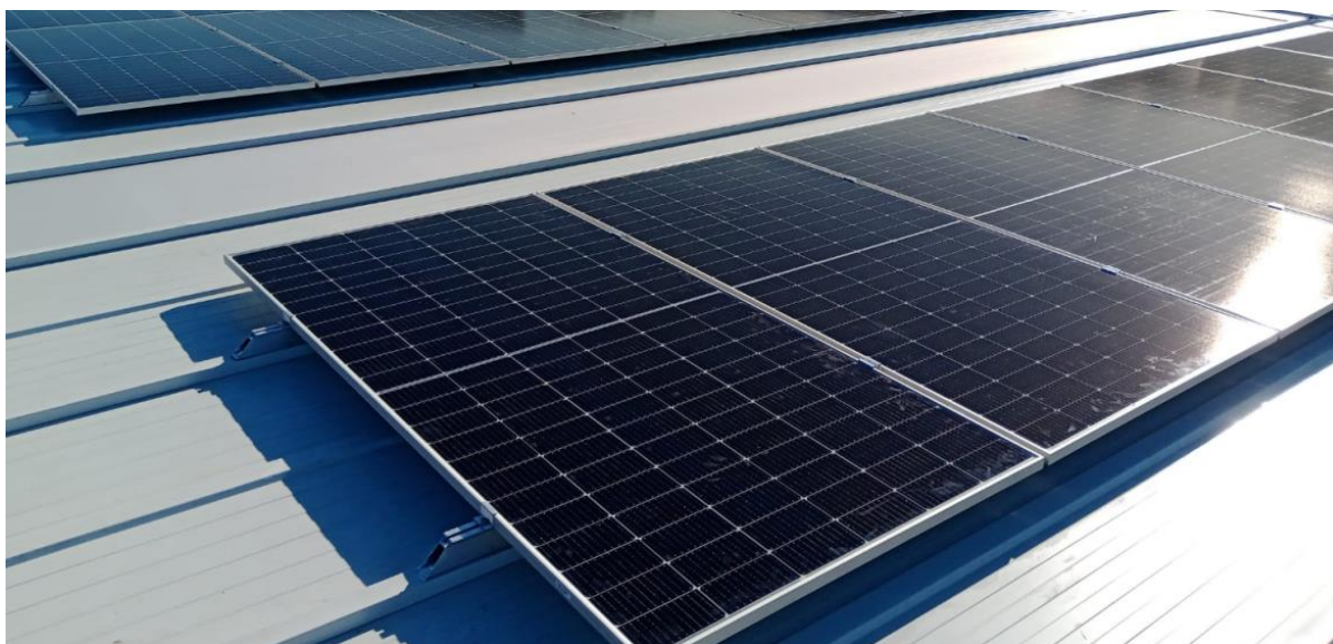
Fig 4. Exemple mòdul monofacial sobre coberta de xapa en orientació horitzontal
