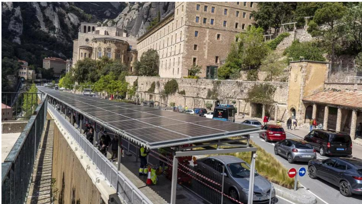
Fig 3. Exemple mòdul monofacial sobre coberta de xapa sobre passarel·la
