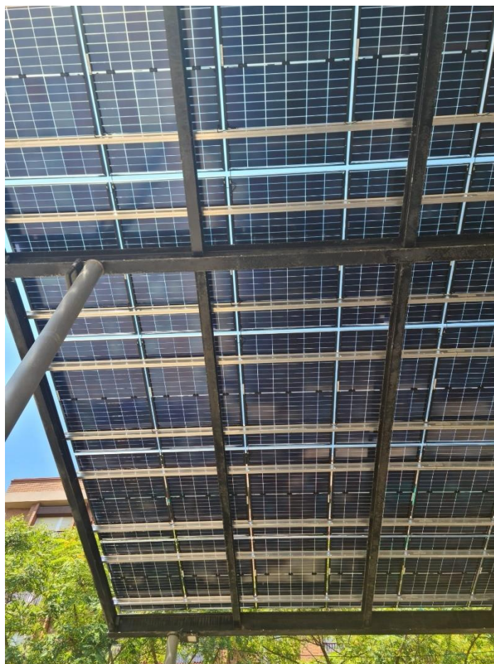
Fig 7. Exemple vista posterior de mòdul Trina Solar TSM-420-NEG9RC.27 sobre pèrgola (fixació costat llarg i doble perfil)
