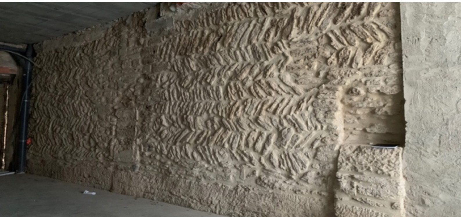
(Detall de la paret en opus spicatum de can Tomàs Teixidor, a la sala que acollirà l'àmbit 1 i 2)
