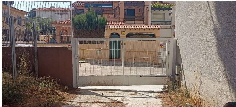
Foto 2. Entrada lateral d'ús exclusiu del personal pel carrer Atzavara.
