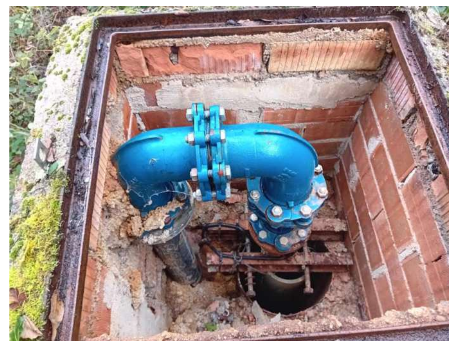
Figura 2. Vista general del Pou de Can Juncà
