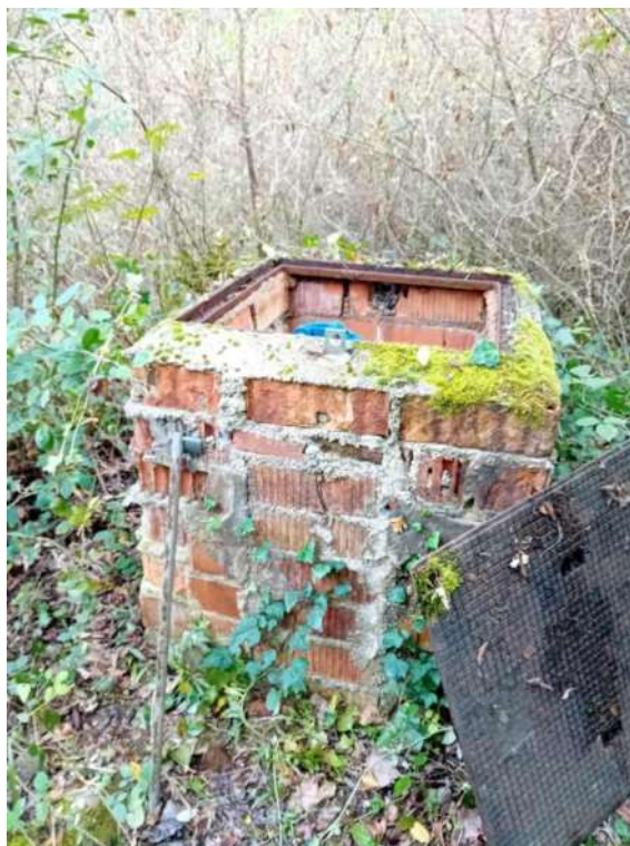
Figura 1. Vista de l'exterior de l'arqueta del Pou de Can Juncà
