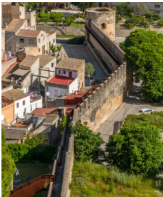
S.01 Muralles de remolins i Torre del Cèlio
