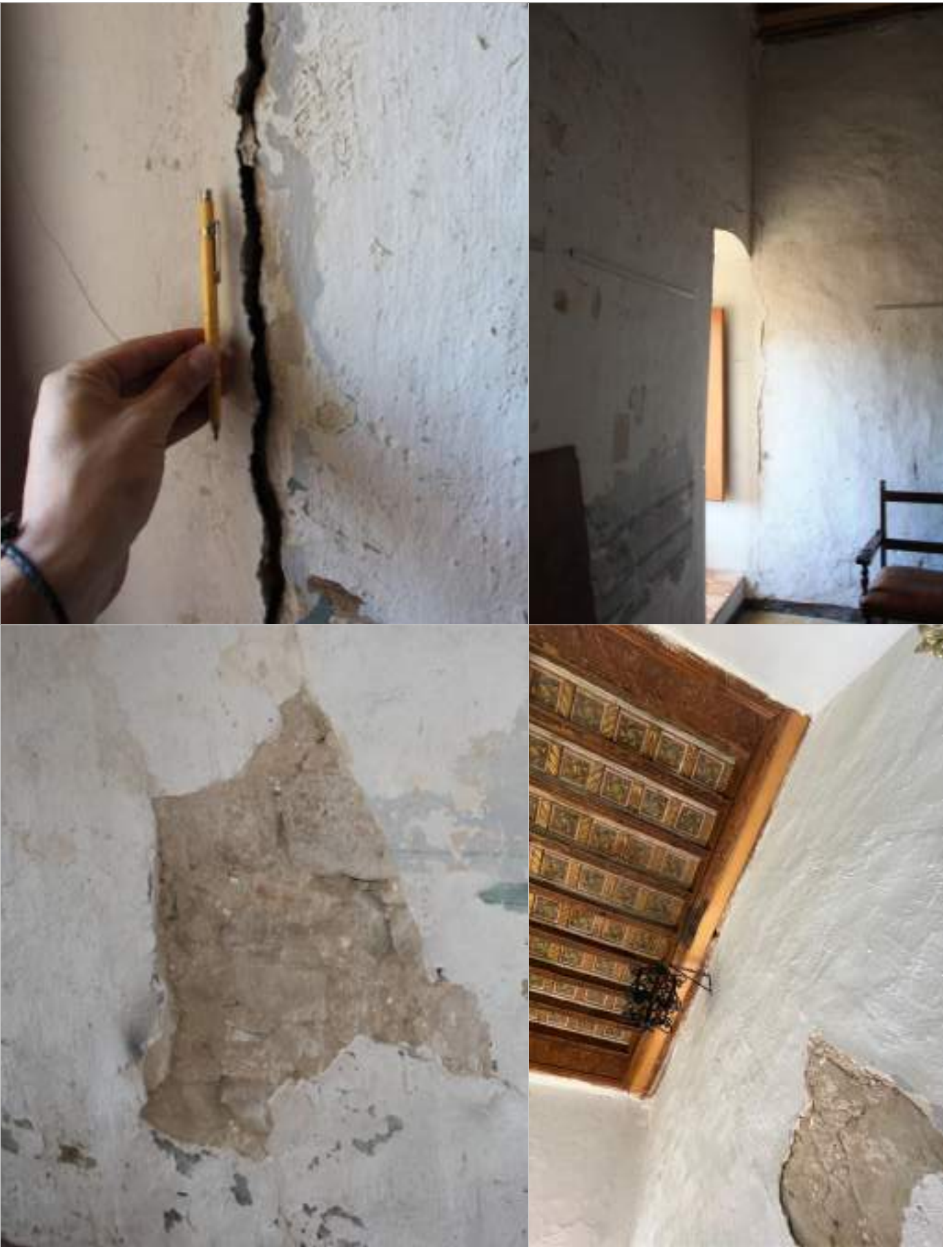
6. Enderroc de paret de maçoneria fruit de les intervencions executades en el moment de la divisió del palau en vivendes. Es pot observar la desconexió de la paret divisòria dels murs de façana, degut a la falta de lligat entre elles. També s'observa que el mur no coincideix amb l'entegnat renaixentista, i que per tant, no existia en la configuració original del palau. Com en el cas anterior, observem la baixa qualitat murària de la mamposteria, gracies al desprendiment de part del revestiment.
