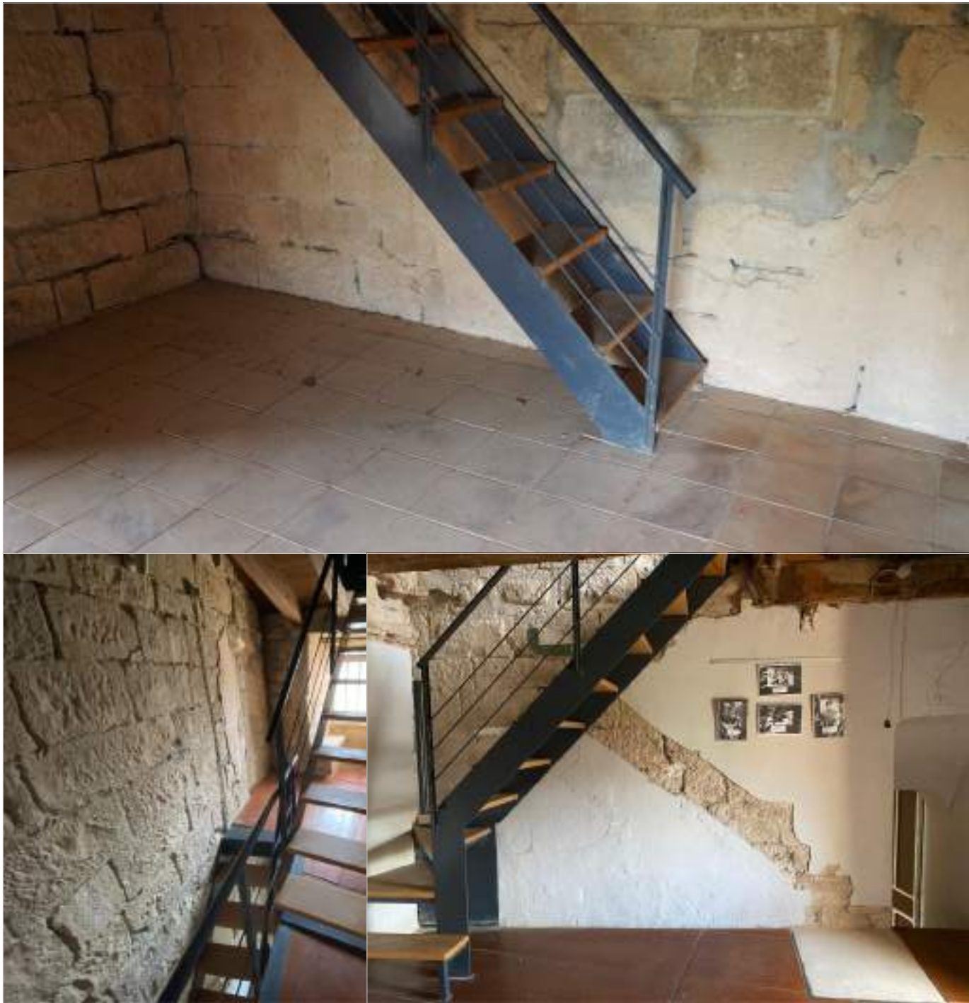
Imatges de les escales existents en el castell resultat de les intervencions anteriors.
