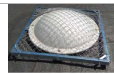
Figura 3. Ejemplo protección claraboyas con enrejado
