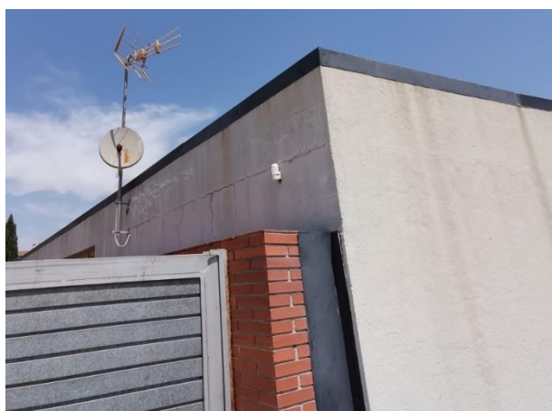
Esquerdes horitzontals en l'arrebossat
