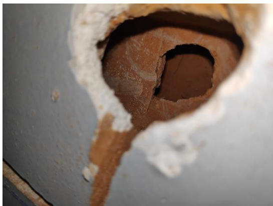
Fotografia de la cala realitzada. Cala Fase I, façana sud-oest
