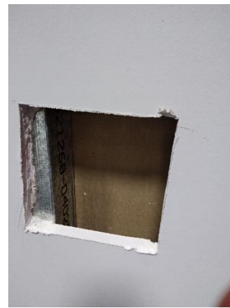
Cala a parament de pladur
