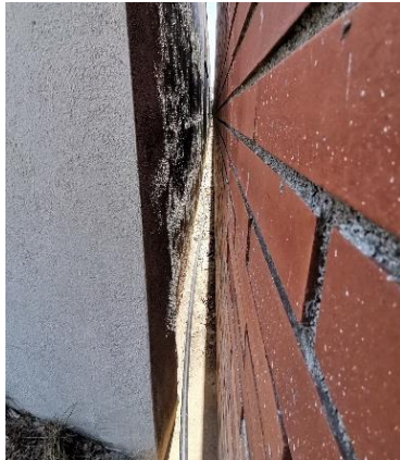
Escletxa entre la façana sud-oest i el mur de tancament amb la parcel·la veïna
