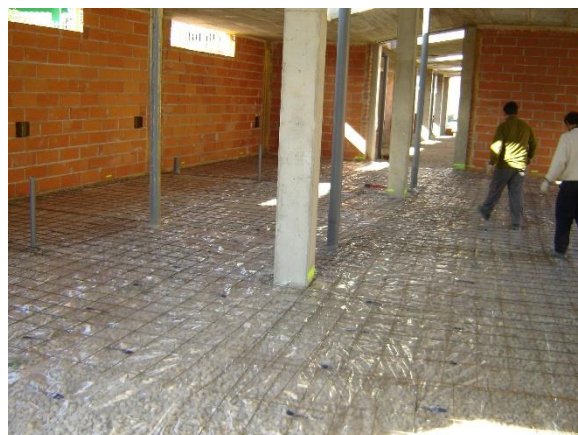
Fotografia en fase d'obra
