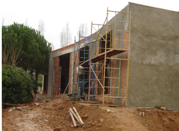
Fotografia en fase d'obra
