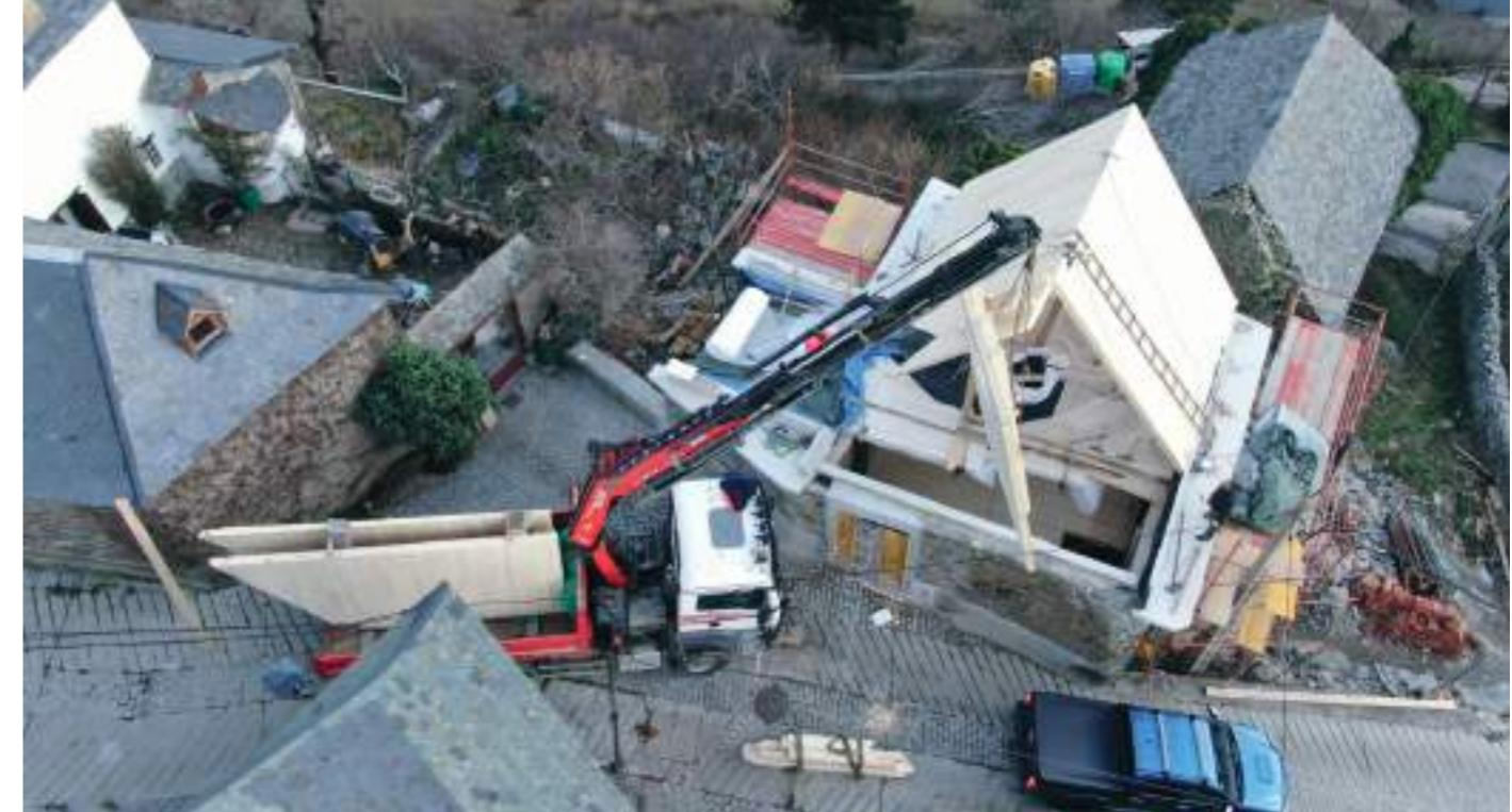
El transporte se realiza directamente de la fábrica a la obra, con camiones aptos para el transporte vertical y horizontal de los paneles.
