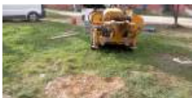
Sondeig S1. Segellat de la perforació
