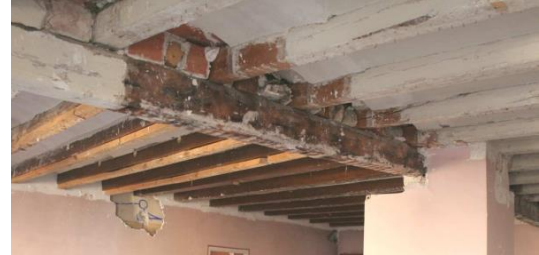
Figura 11. Jàssera de fusta amb forjat de biguetes de fusta
