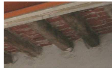
Figura 9. Forjat de rotlle de fusta amb taulell ceràmic
