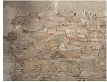
Figura 6. Mur de paredat.
