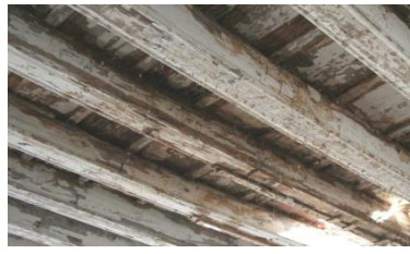
Figura 8. Forjat de fusta amb taulell de fusta
