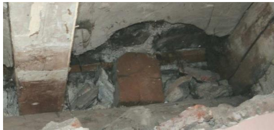
Figura 10. Forjats de revoltos de pissarra
