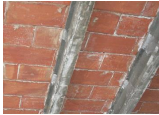
Figura 7. Forjat amb bigueta pretensada i taulell ceràmic
