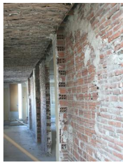
Figura 5. Mur totxana eix 2 a planta tercera.
