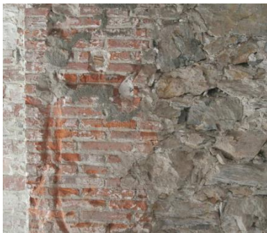
Figura 4. Cantonada creuament eix G/1, canvi de secció de mur
