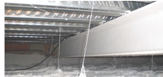
Figura 13. Forjat de xapa col·laborant
