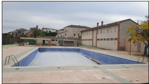
1 VISTA GENERAL ZONA PISCINA. PISCINA GRAN
