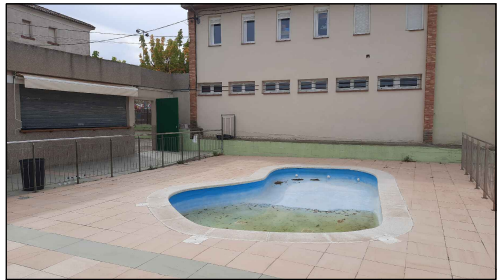
2 VISTA GENERAL ZONA PISCINA. PISCINA INFANTIL
