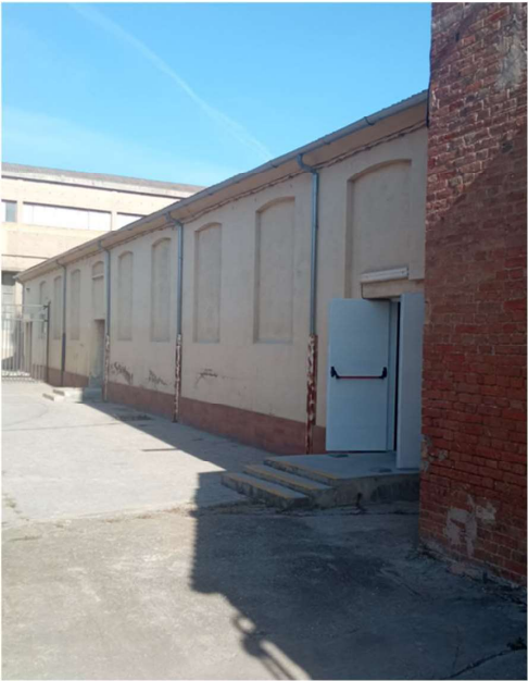
Figura 5. Vista general de l'equipament
