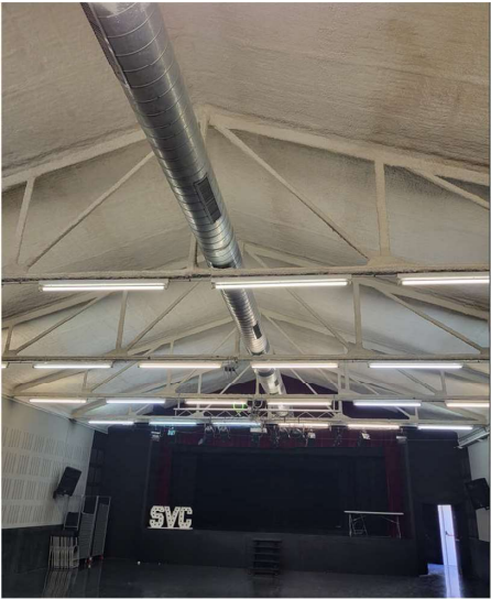
Figura 1. Sistema actual de climatització per conductes
