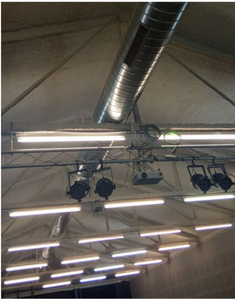
Figura 3. Detall interior de la coberta
