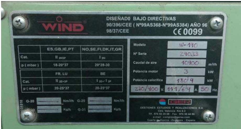
Imatge 2: característiques tècniques del sistema de calefacció
