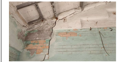
IMATGE DE L'ESQUERDA A TRACTAR
