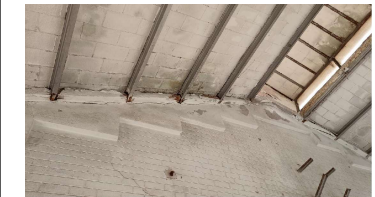
IMATGE DE LES ZONES ON DISPOSAR LES L-120x10
