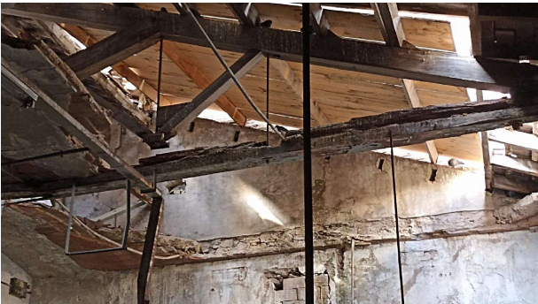
DETALL DE L'ESTAT ACTUAL D'ALGUNES ENCAVALLADES
