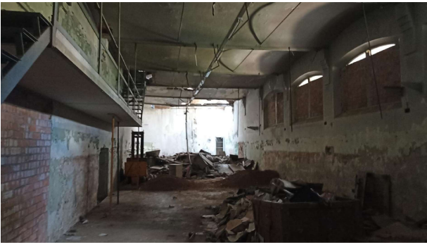
VISTA GENERAL DE LA NAU
