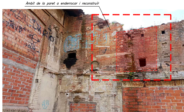
VISTA EXTERIOR DE LA ZONA A REPARAR
