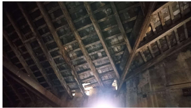
VISTA INTERIOR DE LA ZONA REPARAR
