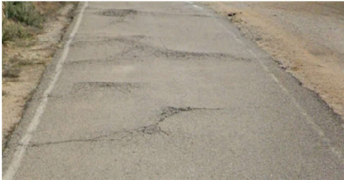
Protuberàncies produïdes per arrels d'arbres
