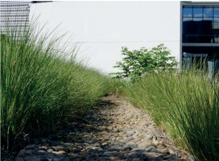
Exemple de cunetes d'infiltració d'aigües d'escorrentia vegetades
