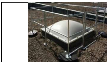
Figura 3. Ejemplo protección claraboyas con barandilla
