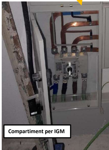
Compartiment per fusibles amb compartiment tipus BUC i sobretensions
