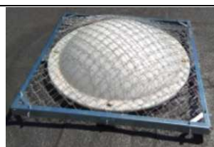
Figura 3. Ejemplo protección claraboyas con enrejado
