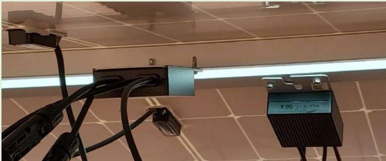
Marc foradat quan el optimitzador té el forat indicat per ser instal·lats en els forats del panell. No confondre els forats del terra amb els forats habilitats per altres utilitzacions com per exemple, acollaments per sota.
