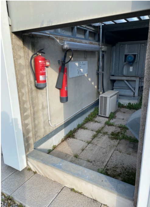
Imatge 3: Paret sala tècnica on s'instal·laran els quadres de proteccions AC/DC i l'inversor
