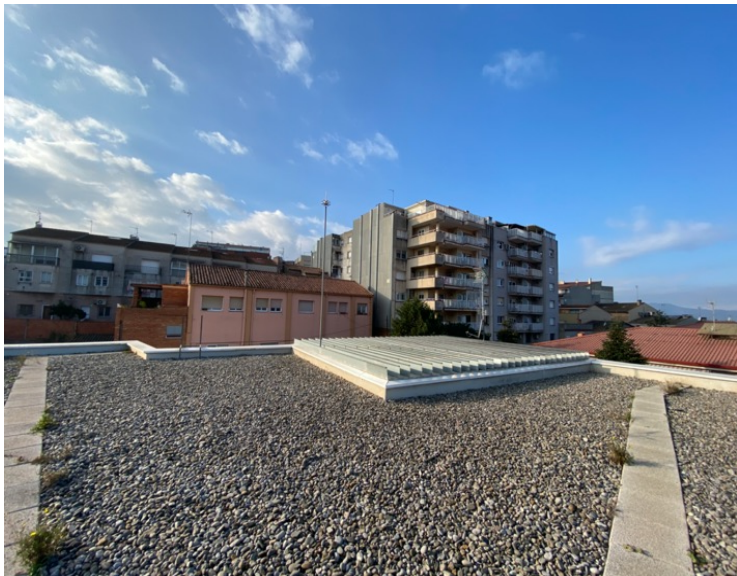
Imatge 2: entrada a sala tècnica des de planta coberta
