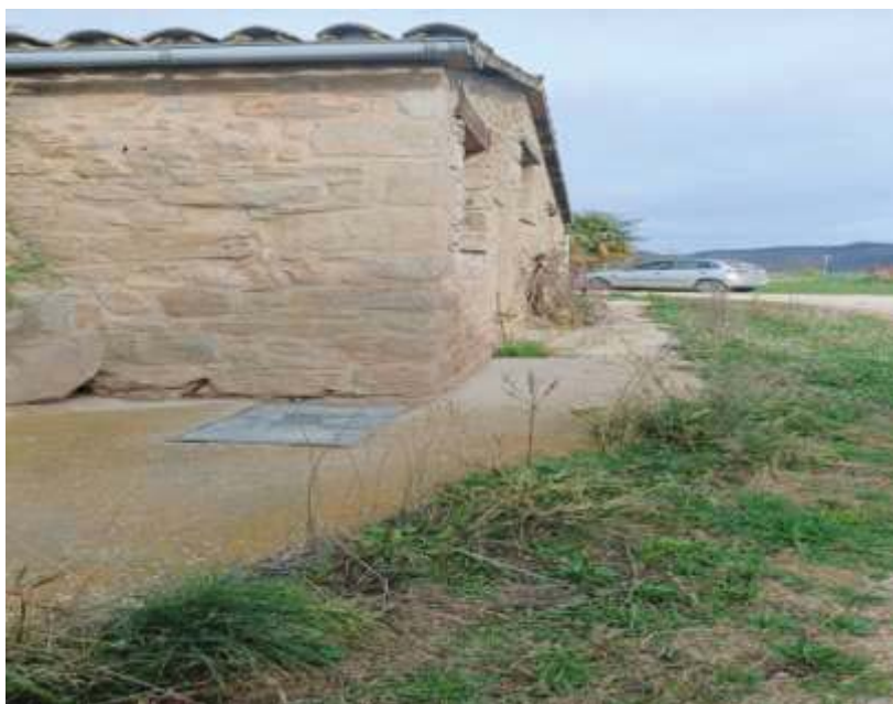
Arqueta comptador de La Serra
