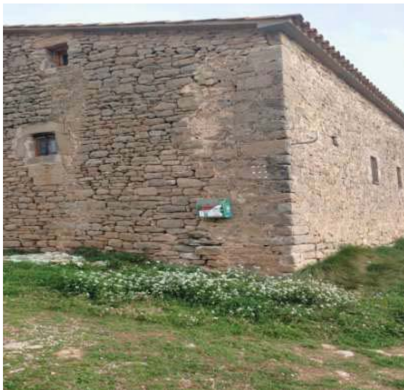
Arqueta comptador de cal Torredadella
