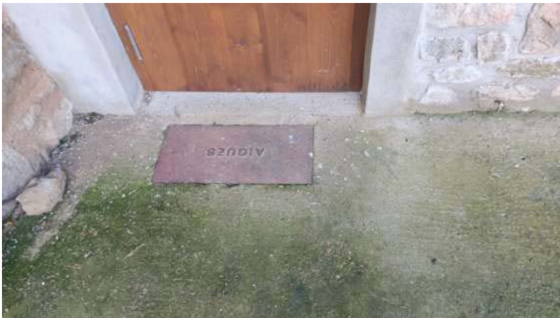
Arqueta comptador de cal Vescomte
