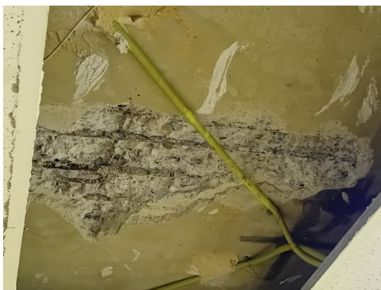
Imatge 4-11. Cala en sostre de planta soterrani -3. Llosa massissa [Windmill]
