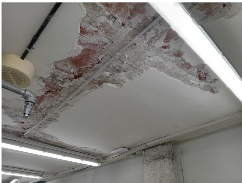
Imatge 4-8. Sostre planta soterrani -2 – Forjat reticular 28+2 cm [Windmill]
