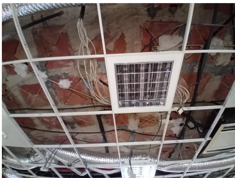
Imatge 4-9. Planta tipus (Sostre planta 3) – Forjat reticular 28+2 cm [Windmill]
