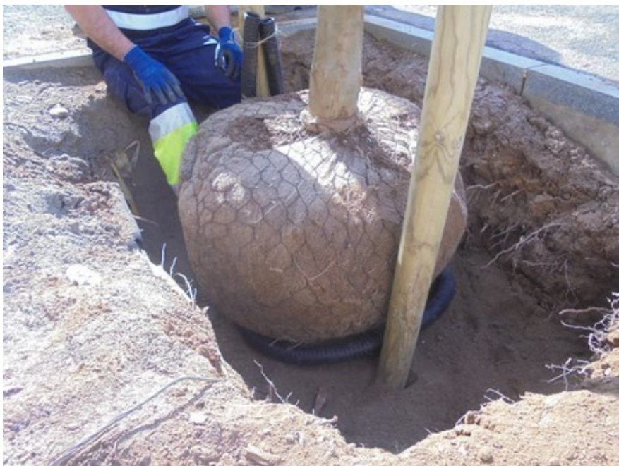
Instal·lació del tub drenant i de les aspres de fusta.
