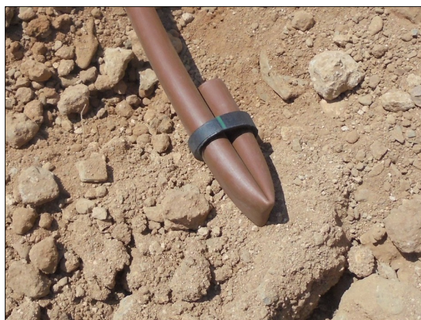
Detall estrangulació final tech-line.
