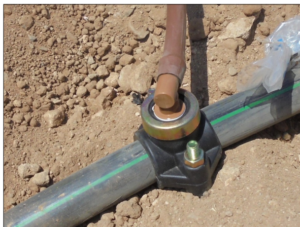
Detall collarí connexió tub PE32Ø.
