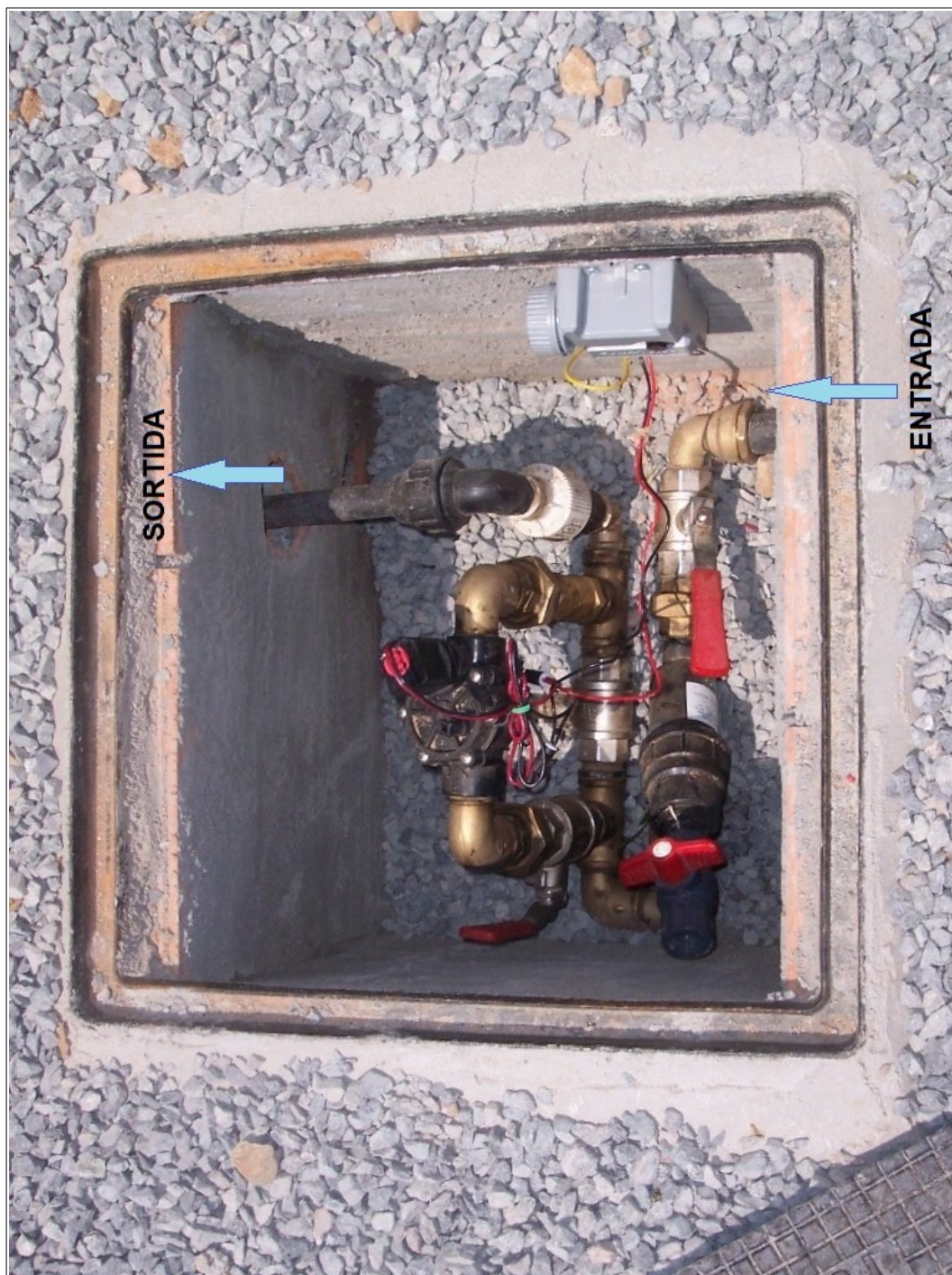
Imatge d'equip de reg amb By-Pass tipus Reus de 32Ø muntat a pericó.
