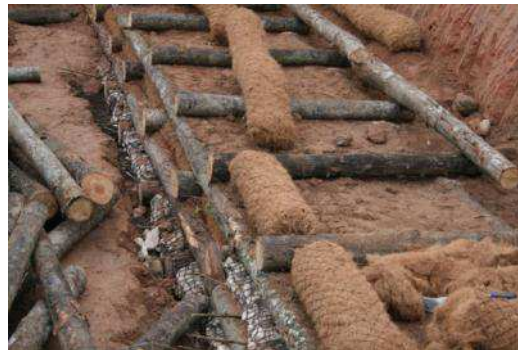
Muntatge dels Fiber rolls en un pis de l'entramat:
