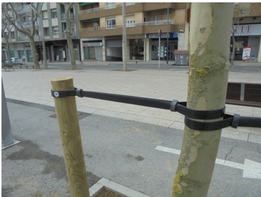
Detall de corretja de subjecció de l'arbre i l'aspa de fusta.
