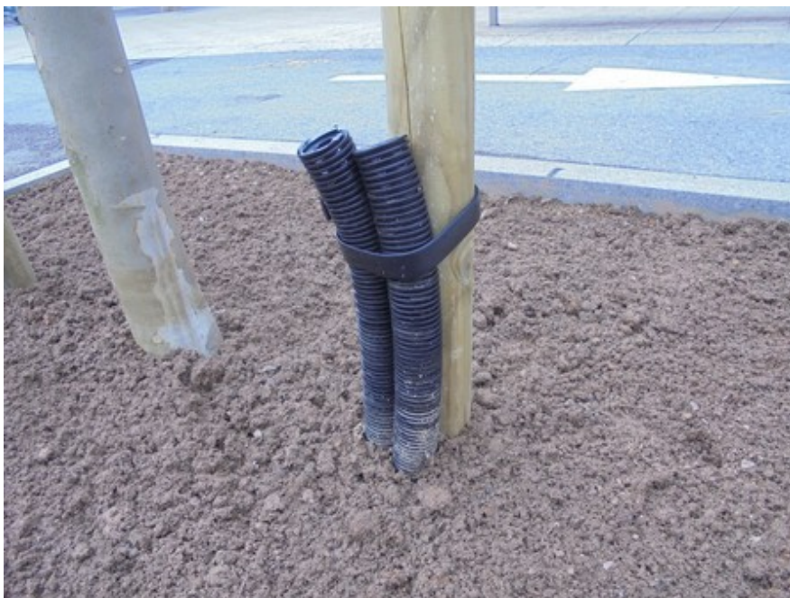
Subjecció del tub drenant a l'aspra de fusta.
