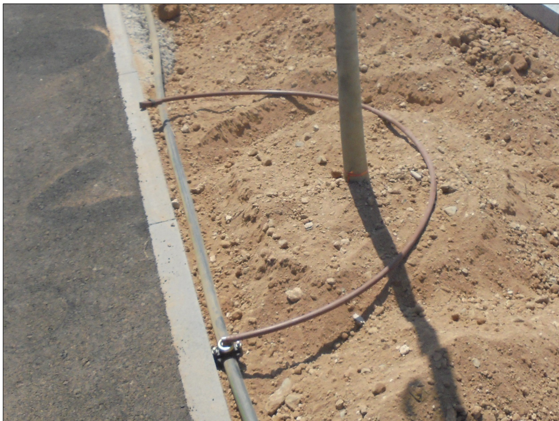
Anella oberta de tech-line de 33 entre goters per reg arbrat viari.
