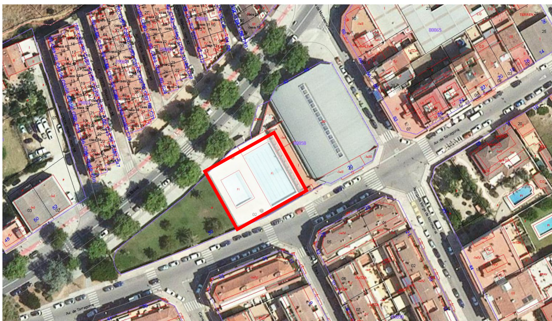
Figura 1. Àmbit de les obres.
