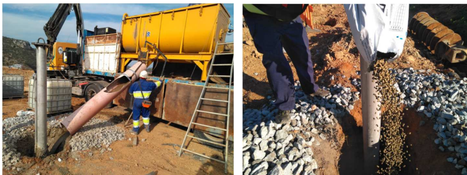
Exemple de segellat del pou amb bentonita-ciment i amb pel·let de bentonita
