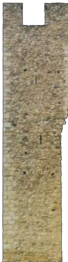
TORRE 14 BANDA DRETA
