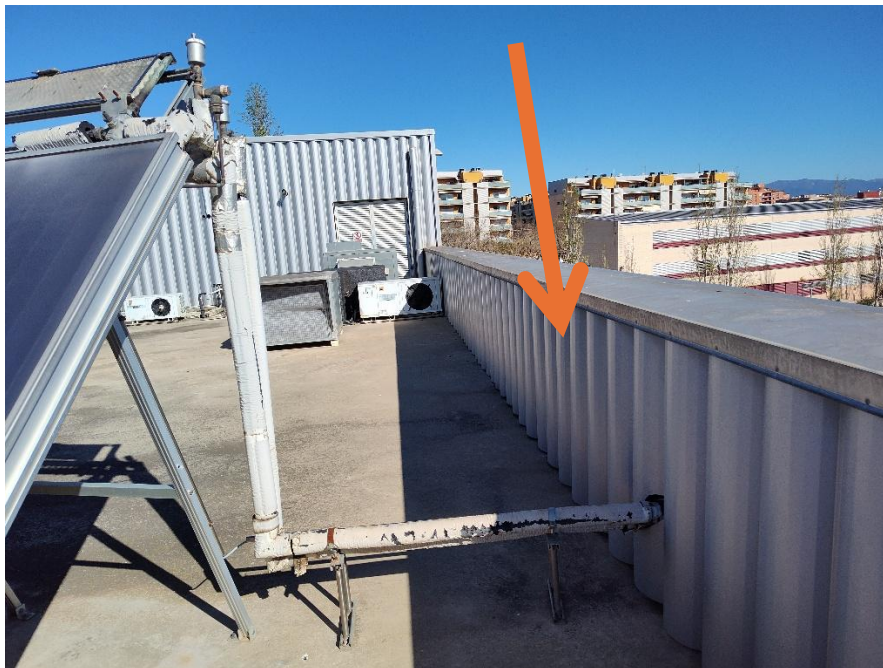
Imatge 1. Estat actual de la xapa metàl·lica a desmuntar i tornar a muntar
