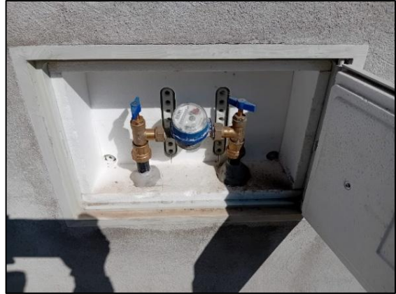
Foto 2. Comptador de façana al carrer Major.
