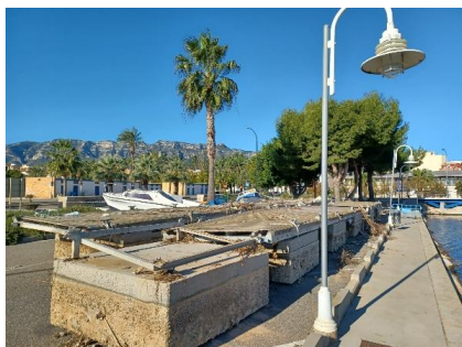
Abassegament del pantalà trencat
