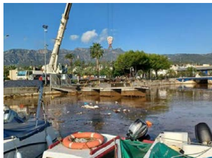
Retirada del pantalà trencat
