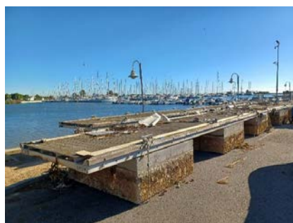
Abassegament del pantalà trencat
