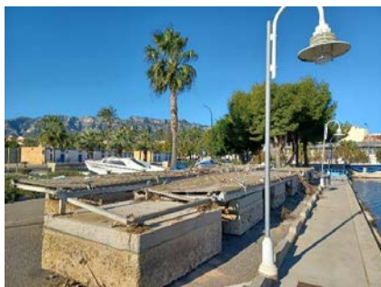
Abassegament del pantalà trencat
