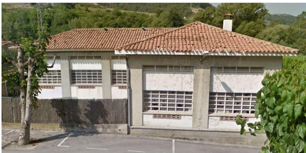
FAÇANA PRINCIPAL ANTIC ESCORXADOR
