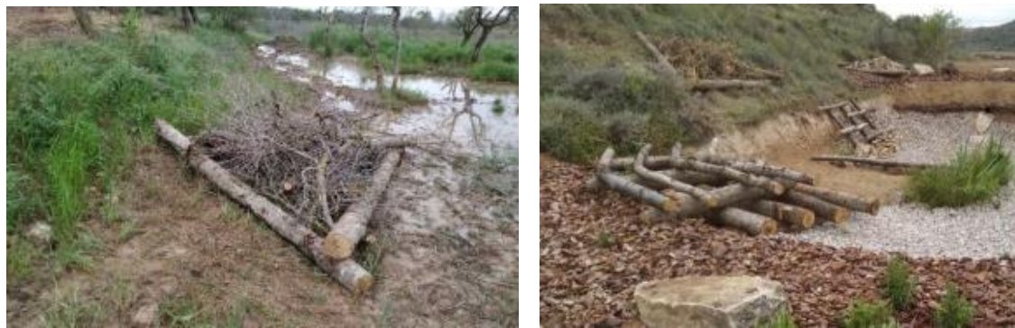
Figura 1 Imatge d'estructura de biodiversificació amb brancada i exemple d'aplicació en una obra executada per Naturalea.
