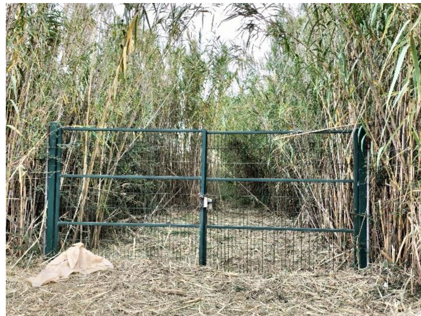
Figura 2 Imatge de la porta i tanca metàl·liques - punt d'accés a obra
