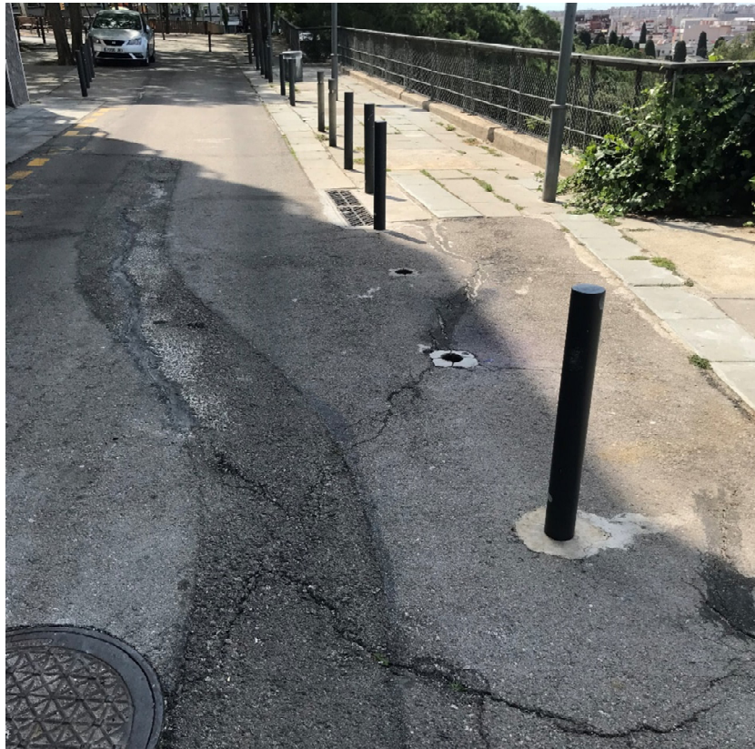
Figura 9: Esquerdas paral·leles a façana Carrer Esmaragda 2-12
