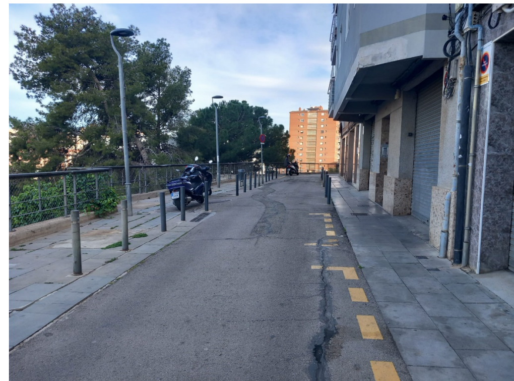
Figura 4: Esquerdas paral·leles al Carrer Esmaragda 2-12
