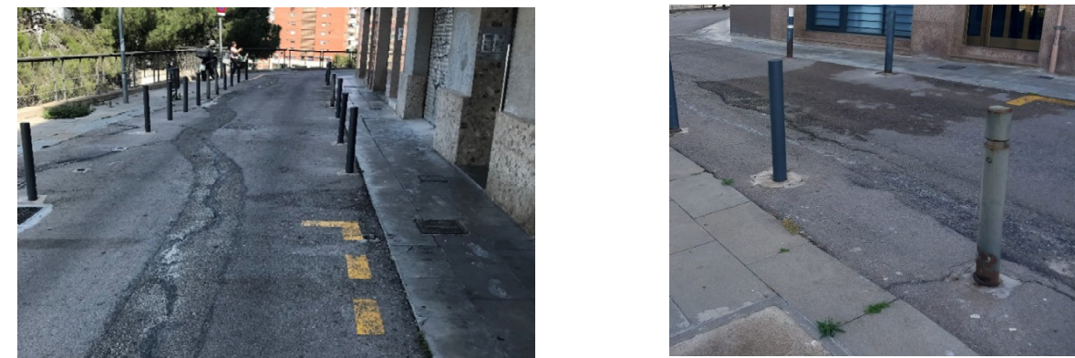
Figures 1 i 2: Fissures paral·leles a façana
