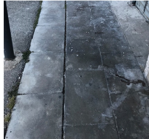
Figura 4: Esquerda paral·lela a façana
