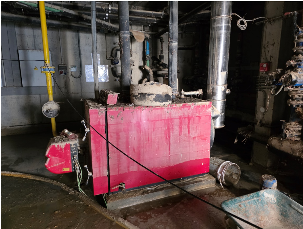
F9. Planta soterrani. Sala de calderes 2 després del buidat.
