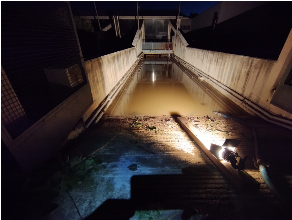
F7. Rampa d'accés al soterrani durant el buidatge.
