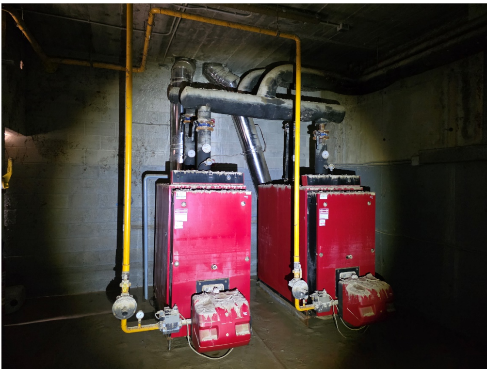
F10. Planta soterrani. Sala de calderes 1 després del buidat.
