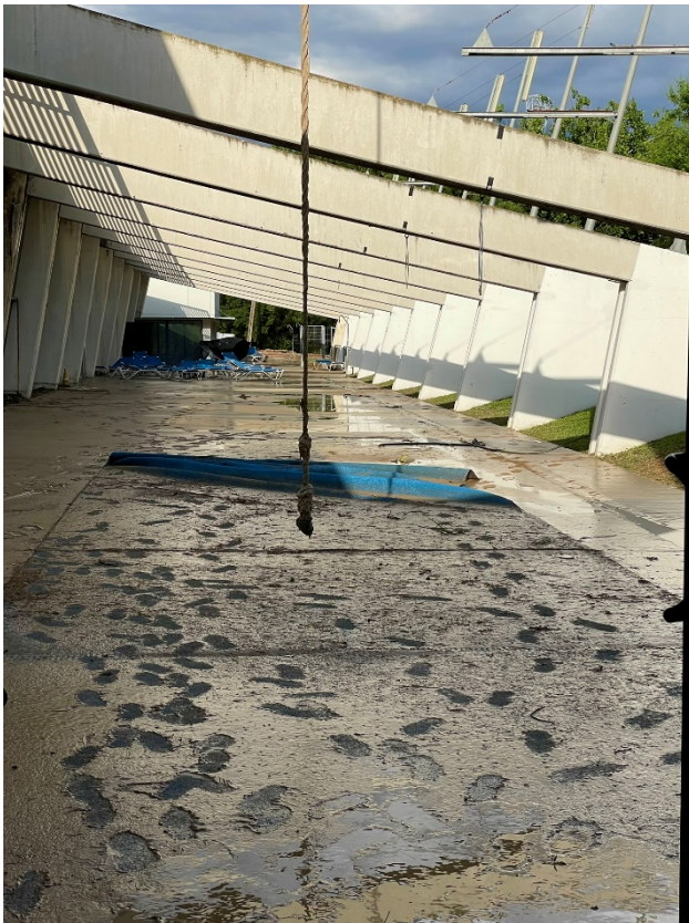
F6. Zona exterior.
