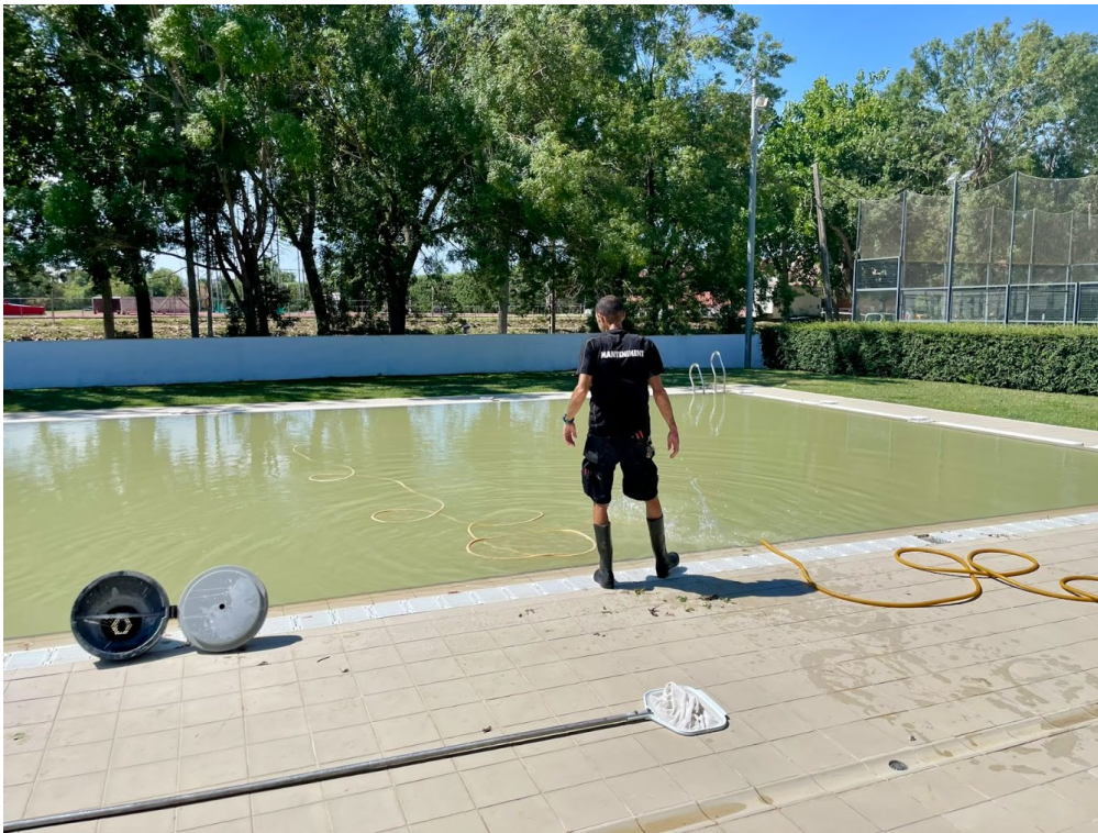
F13. Piscina exterior després de les afectacions.
