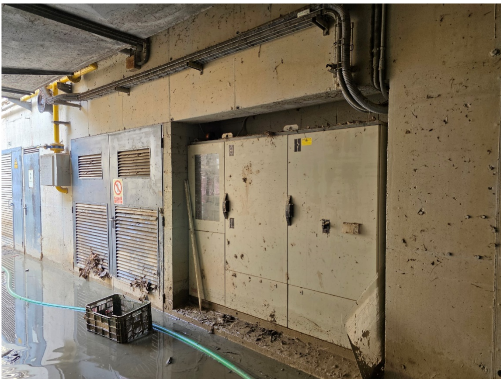
F12. Planta soterrani. Accés ET i quadre general després del buidat.
