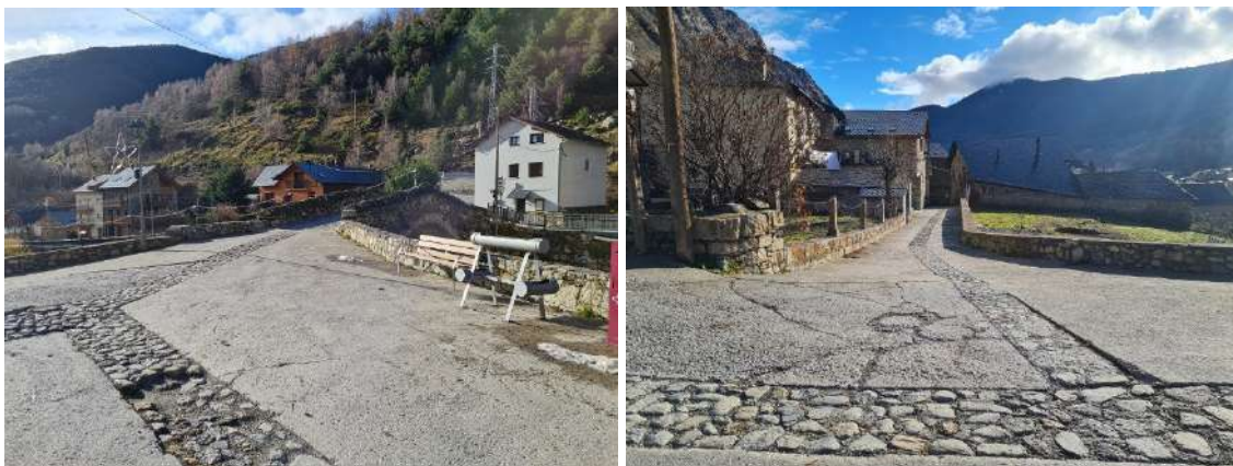
Imatge 2. Plaça del Molí: vista cap al Pont de la Capella i cal al Carrer de Subenuix. Veiem el paviment de formigó esquerdat i els camins de pedra desfets.
