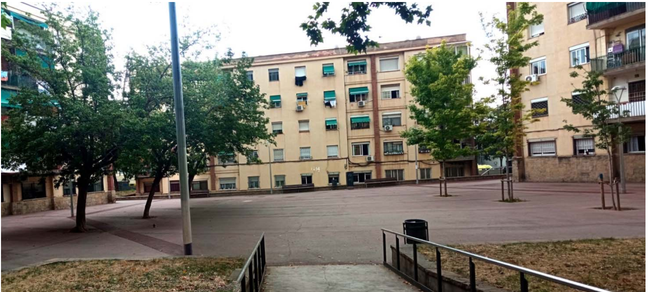
Foto. Subàmbit 1. Estat actual
