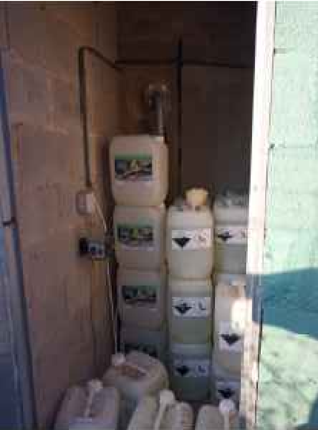
CASETA DE CLORACIÓ EXISTENT
