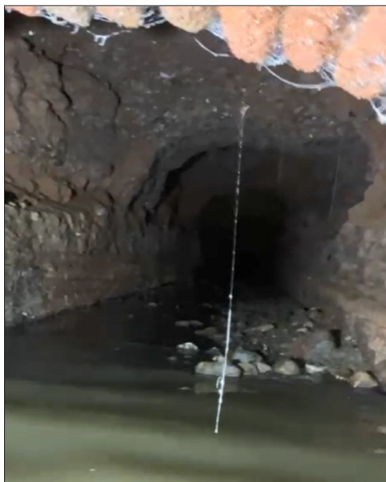
Tram de galeria sense sostre amb alçada variable 150 - 260 cm i 120 cm d'ample
