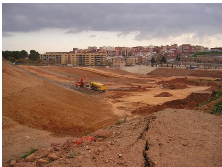
Vista general dels rebaixos de terra realitzats amb excavadora giratòria.
