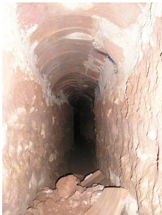
Vista de l'interior de la galeria de la mina d'aigua de Can Tries I.
