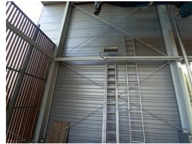
Imatge 91. Estructura metàl·lica
