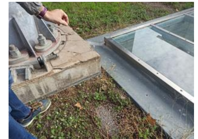
Imatge 80. Base pilona estació Mirador
