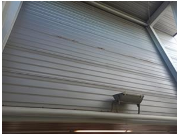
Imatge 43. Lateral de zinc
