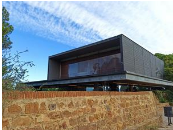
Imatge 63. Coberta de zinc
