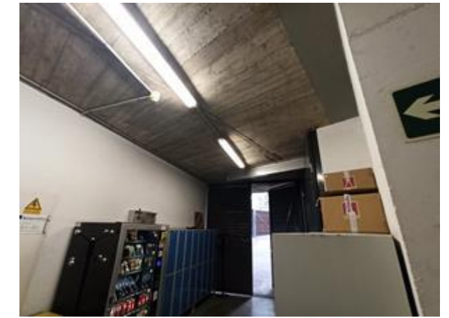
Imatge 56. Zona àrees tècniques
