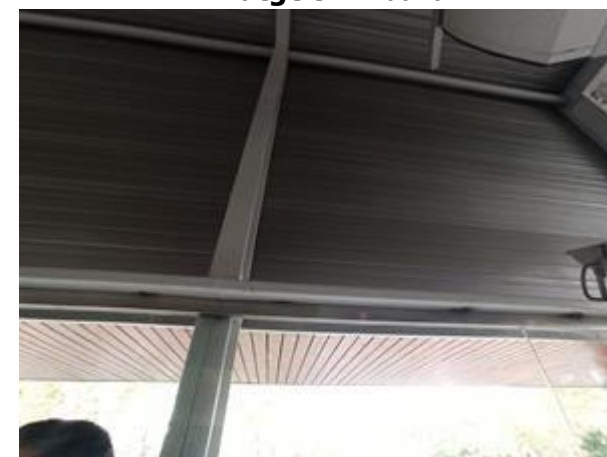
Imatge 11. Estructura i coberta de zenc
