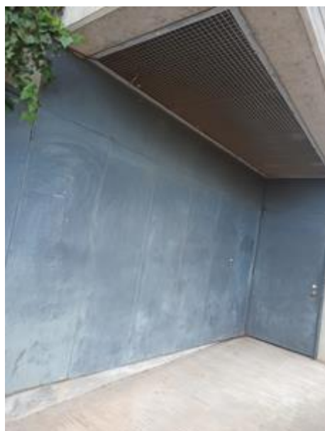
Imatge 67. Portes exteriors
