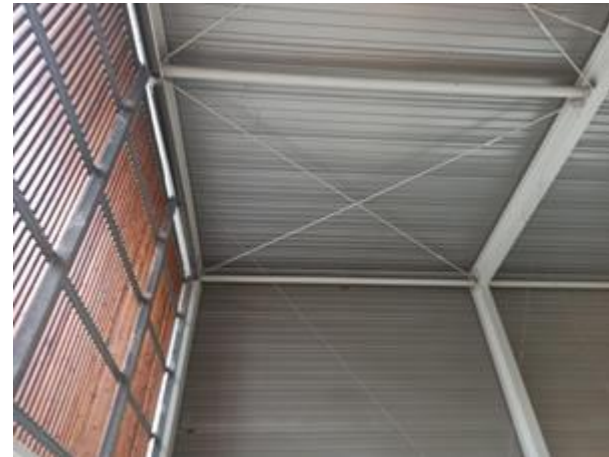
Imatge 2. Estructura metàl·lica i coberta de zenc reparar
