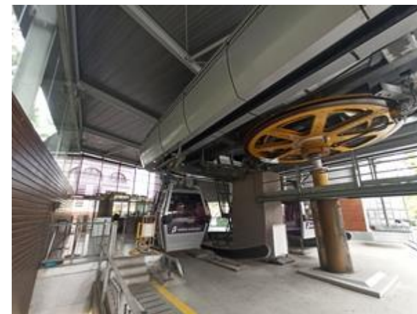
Imatge 7. Fossat d'estació
