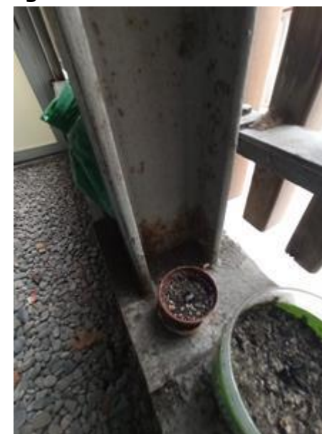
Imatge 47. Estructura pati exterior
