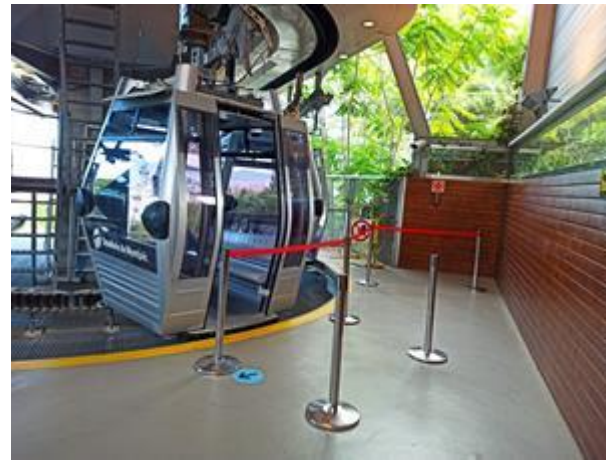
Imatge 62. Andana estació Castell a pintar
