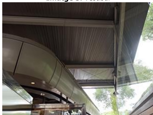
Imatge 5. Interior vestíbul
