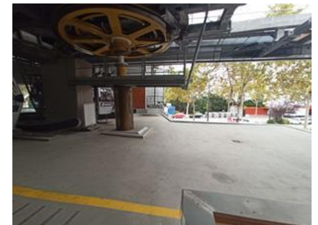
Imatge 8. Fossat d'estació
