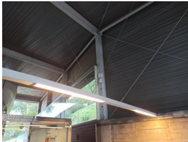
Imatge 9. Coberta de zinc
