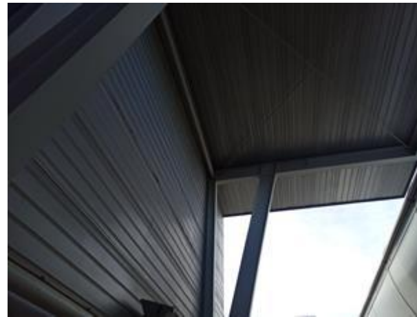
Imatge 44. Coberta de zinc
