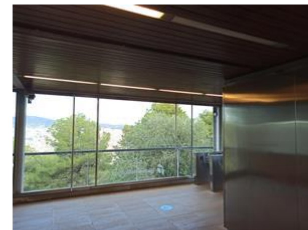
Imatge 70. Enllumenat vestíbul
