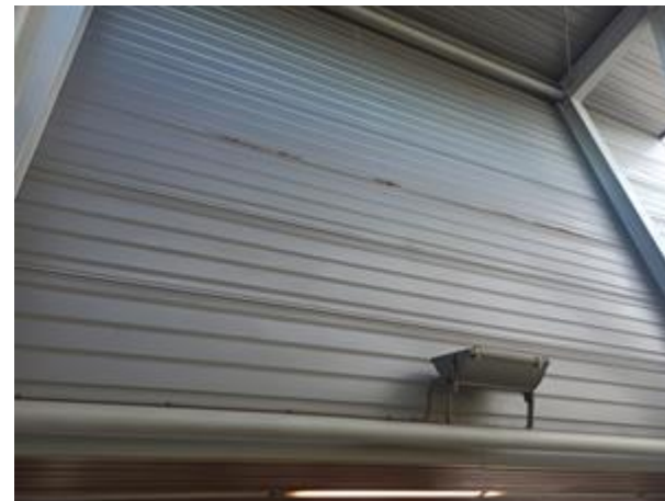
Imatge 76. Estructura/Coberta metàl·lica
