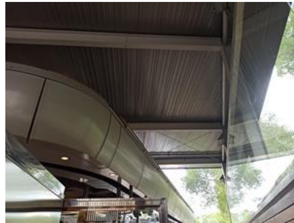
Imatge 10. Coberta de zinc
