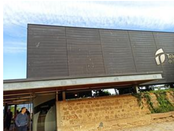
Imatge 64. Coberta de zinc
