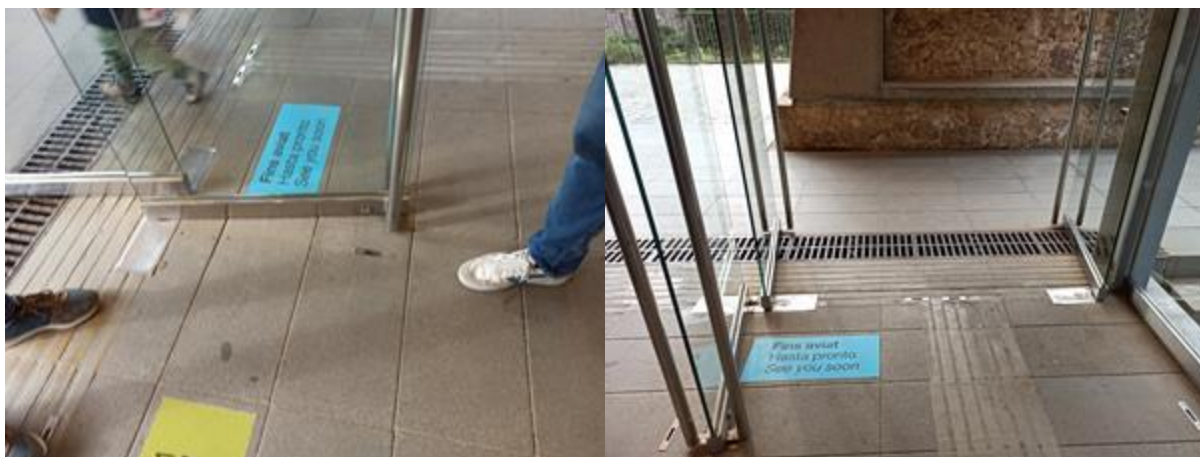
Sistema de tancament a substituir
