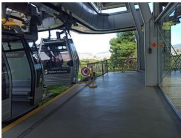
Andana estació Mirador a pintar
