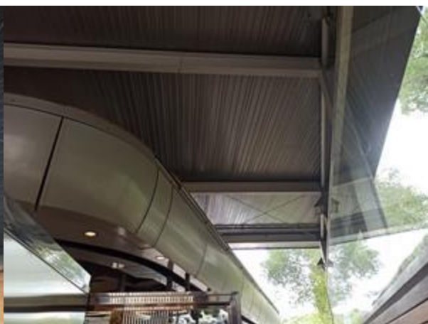
Coberta de zinc
