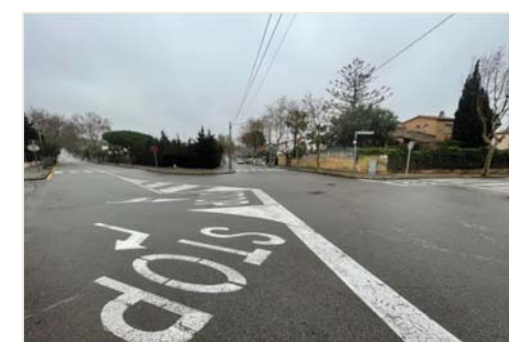
13. encreuament Av. Diagonal Av. 319
