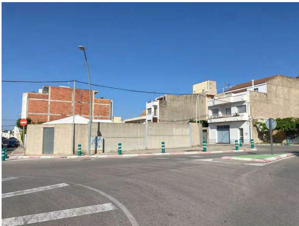
Imatge 5. Ubicació vàlvula reguladora de pressió general
