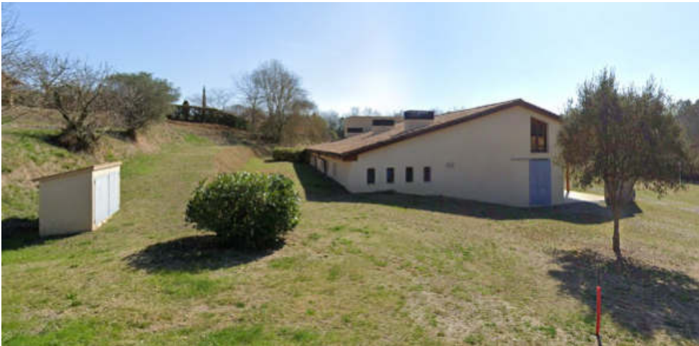
Vista nord-oest del Local Social amb armari de l'escomesa actual a l'esquerra de la imatge
