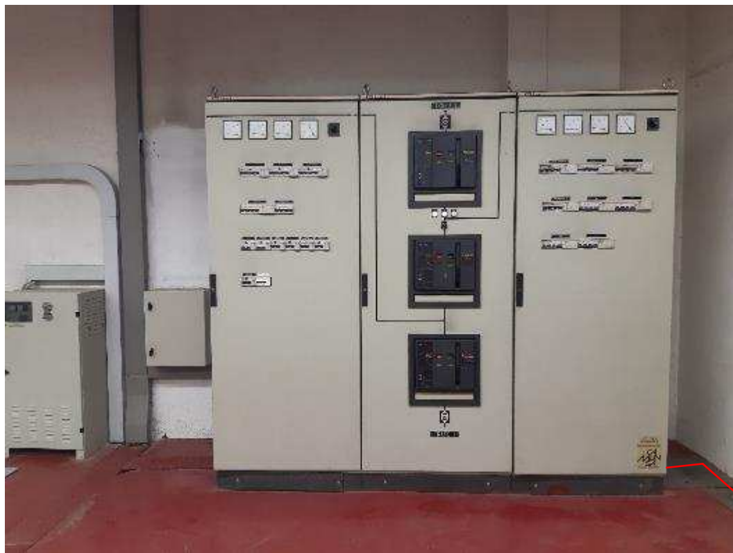
Imatge 26. Detall d'estesa des de quadre de commutació de BT
