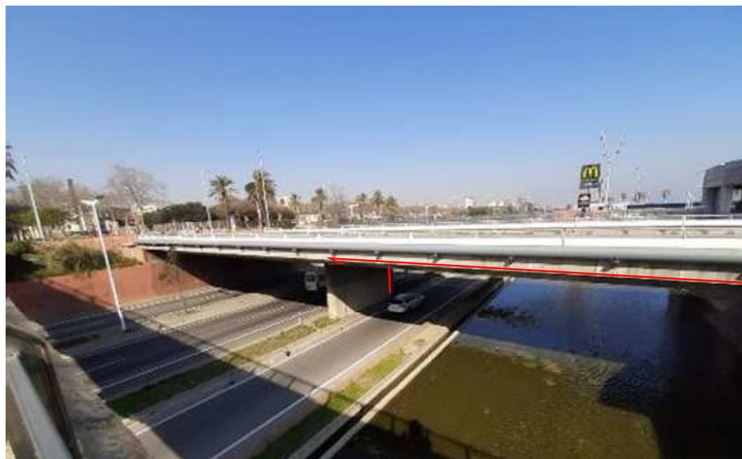
Imatge 32. Detall tram engrapat al llarg de l'estructura del carrer Jaume Vicens i Vives
