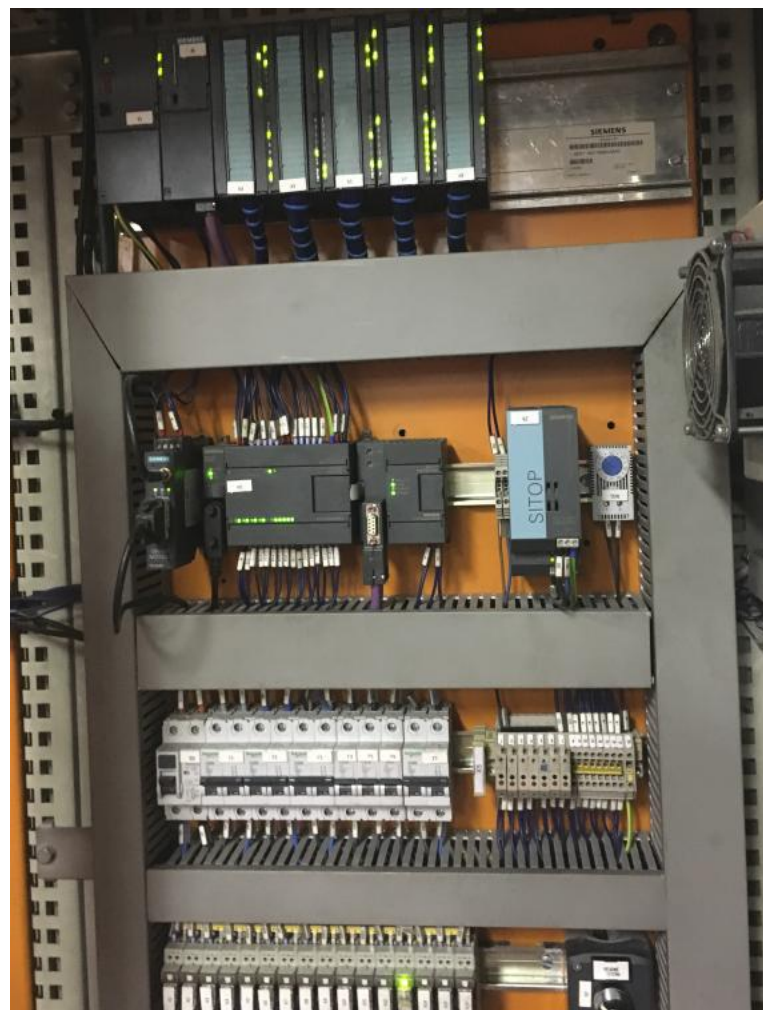
Imatge 9. Posició del mòdul MD720-3 a substituir
