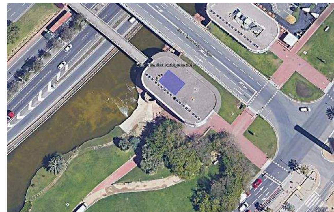
Imatge 5. Emplaçament de la Sala Tècnica d'Autogeneració
