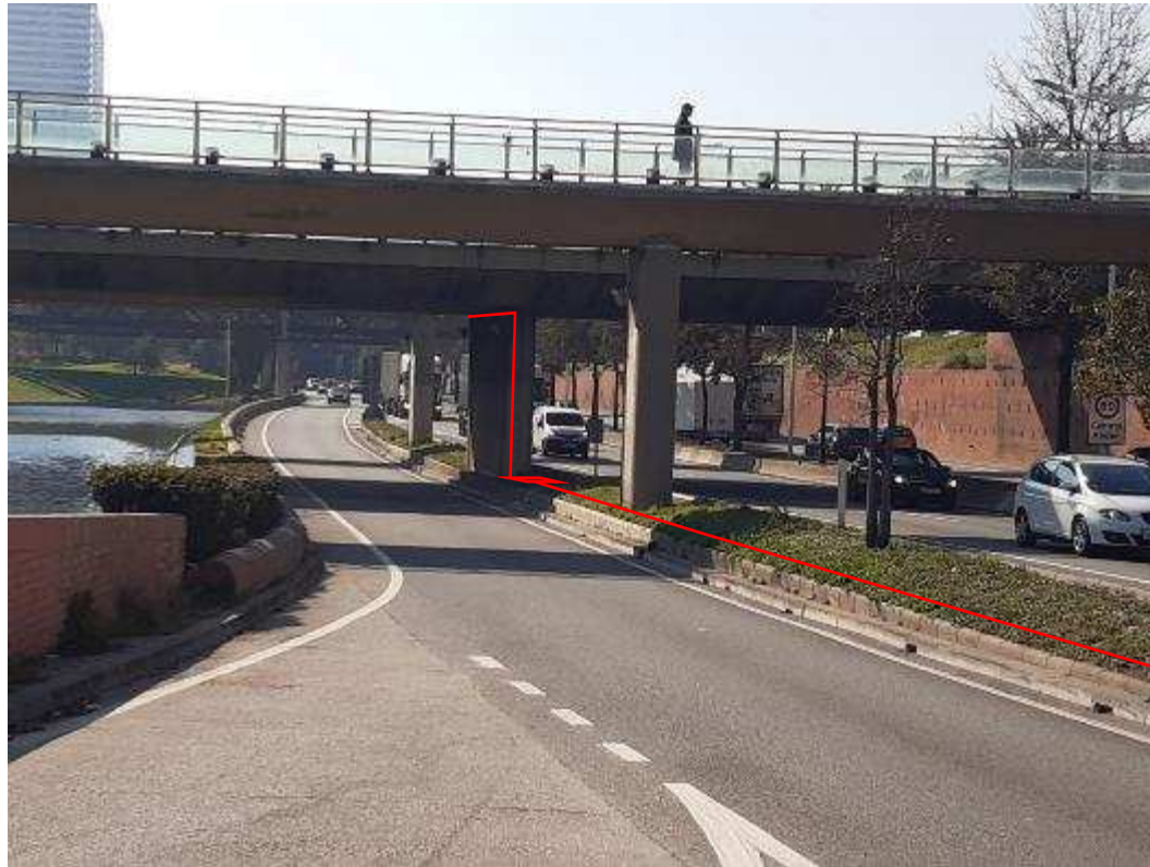
Imatge 35. Inici del tram soterrat a la Ronda Litoral, a l'alçada del carrer Jaume Vicens i Vives
