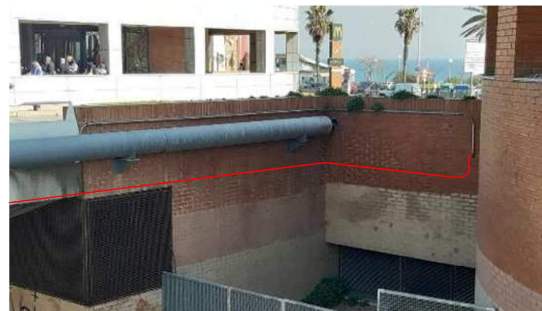
Imatge 31. Inici tram engrapat per exterior de ST d'Autogeneració
