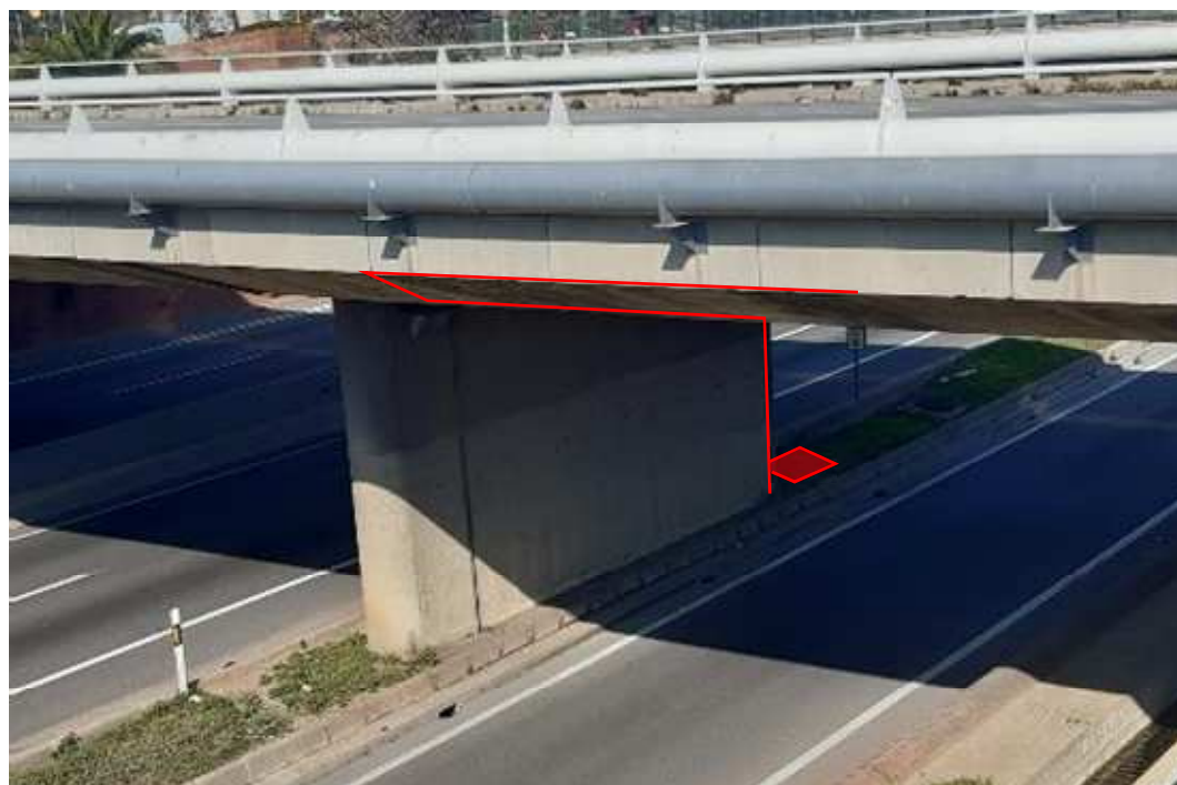
Imatge 33. Detall finalització tram engrapat al peu del pilar de l'estructura del carrer Jaume Vicens i Vives
