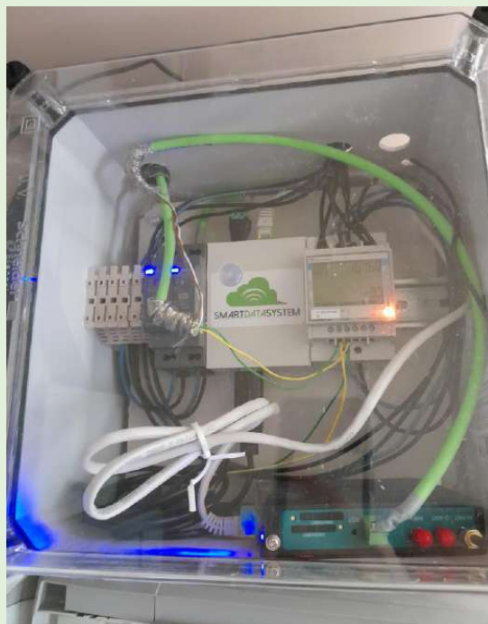
Exemple de caixa amb equips de monitoratge i poca ventilació.
