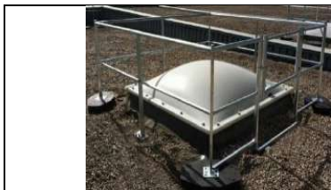
Figura 3. Ejemplo protección claraboyas con barandilla
