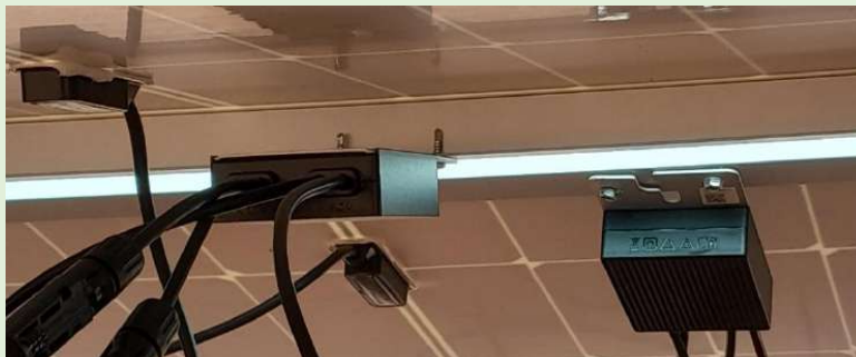
Marc foradat quan el optimitzador té el forat indicat per ser instal·lats en els forats del panell. No confondre els forats del terra amb els forats habilitats per altres utilitzacions com per exemple, acolliments per sota.
