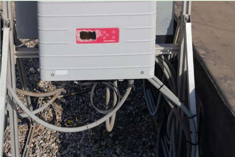
Degradació del display d'un inversor degut a l'exposició solar directa.
