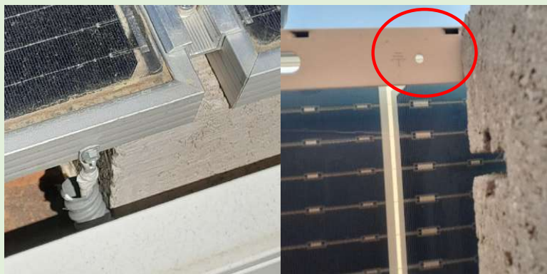
Lateral del marc foradat quan el propi mòdul ja té el forat indicat per instal·lar el terra.
