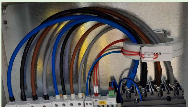
Exemple d'un quadre elèctric amb proteccions AC on s'utilitzen punteres i terminals
